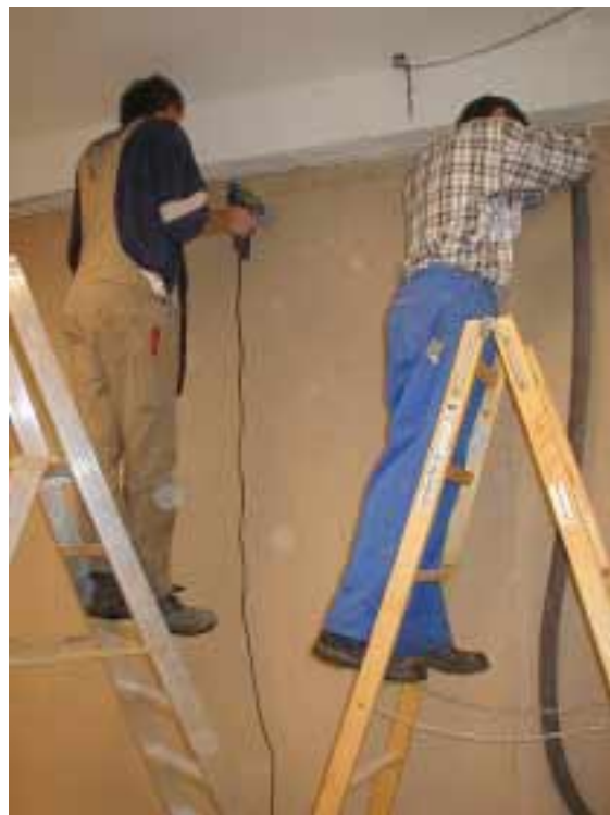
Figur 3.11. Boring af huller samt indføring af slange i væg nr. B2
