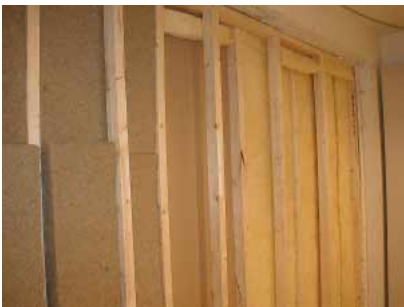
Figur 3.7. Udskiftning af glasuld med høruld i væg med dobbelt skelet (væg nr. C1 og C2)
