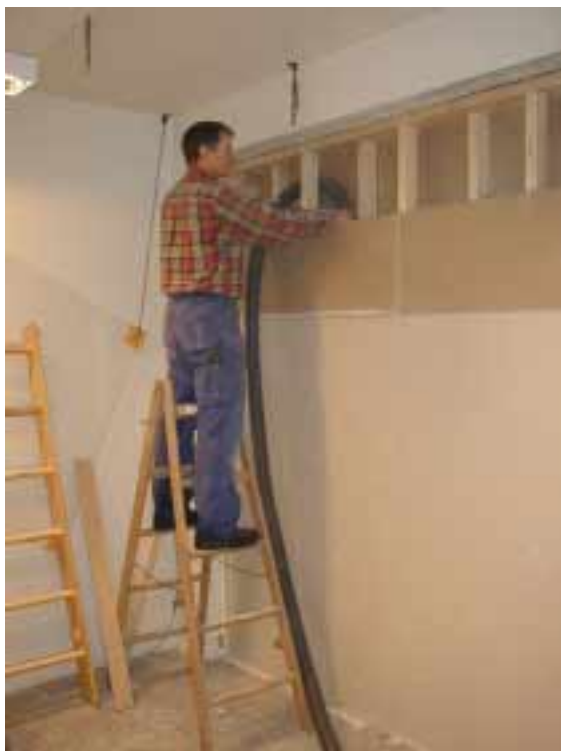
Figur 3.13. Indledende indblæsning i væg nr. C3
