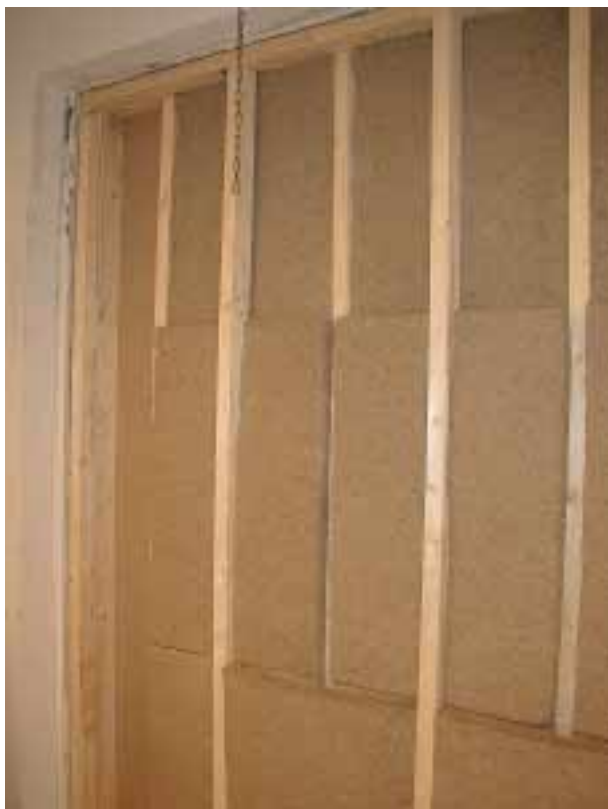
Figur 3.8. Placering af tre lag høruldsplade i væg nr. C2
