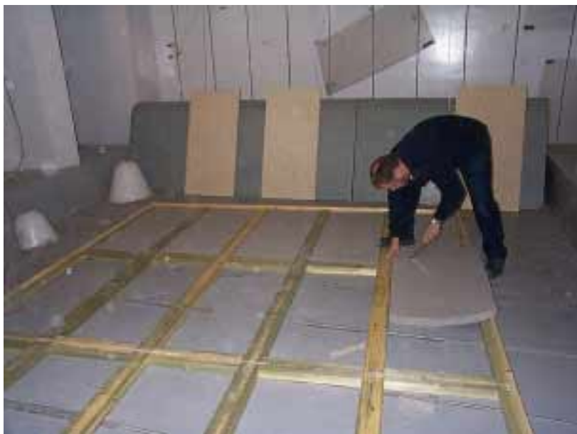
Figur 4.4. Tilskæring og udlægning af celluloseuldsplader
