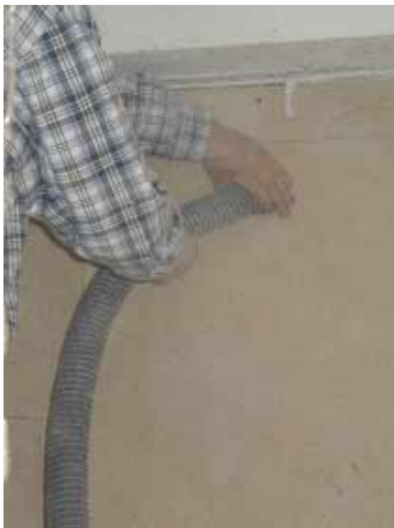
Figur 3.12. Indblæsning i væg nr. B2
