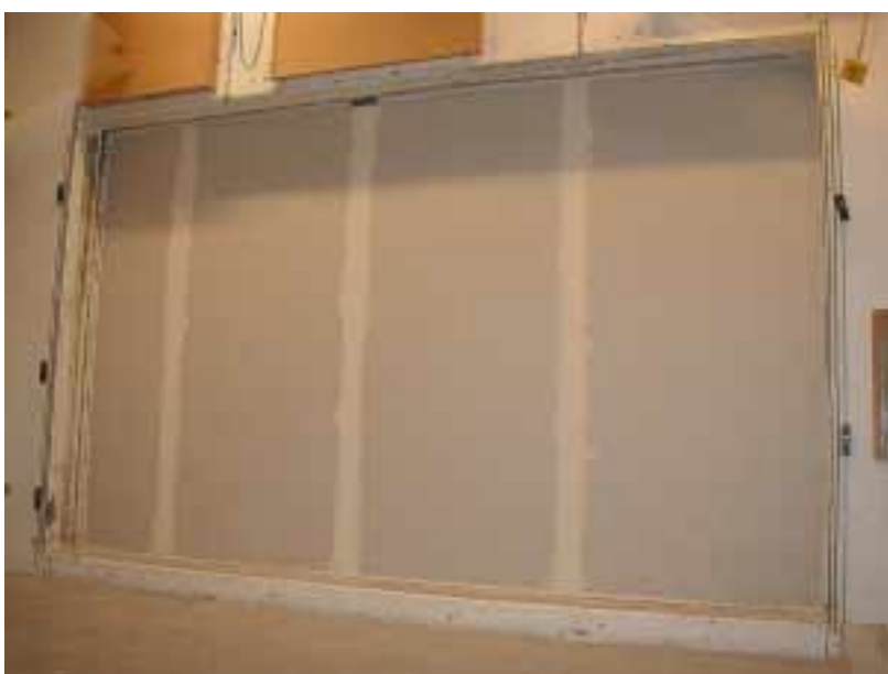
Figur 3.5. Væg nr. B1 set fra senderummet efter tapening og spartling af samlinger mellem gipsplader
