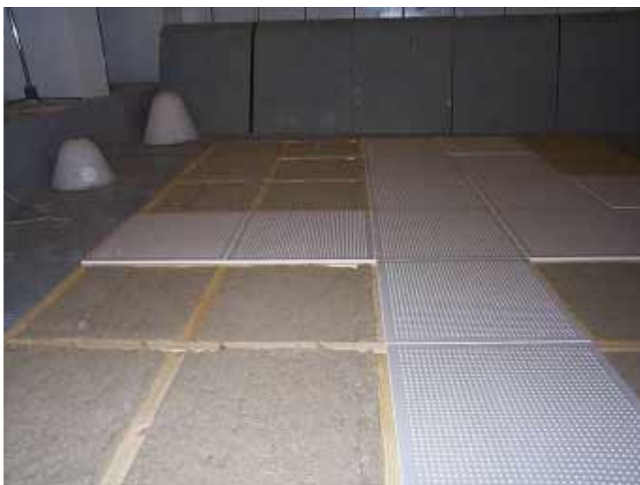
Figur 4.3. Absorbent med høruld efter delvis montering af perforerede gipsplader
