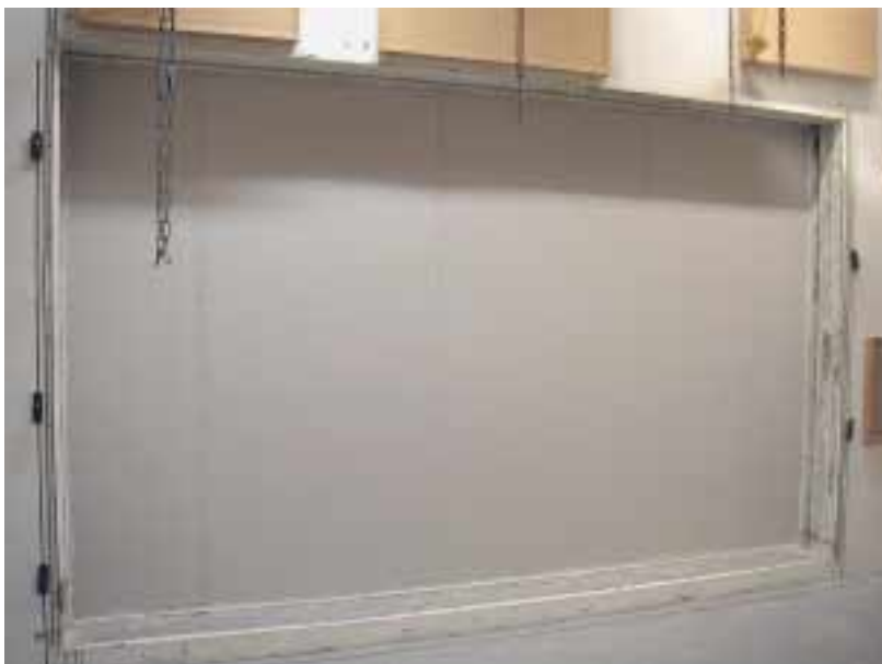
Figur 3.4. Væg nr. A1 set fra senderummet før tapening og spartling af samlinger mellem gipsplader
